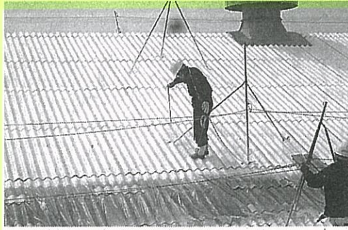
断熱機能は15年間持続するとしている(福岡県内の施工現場)
