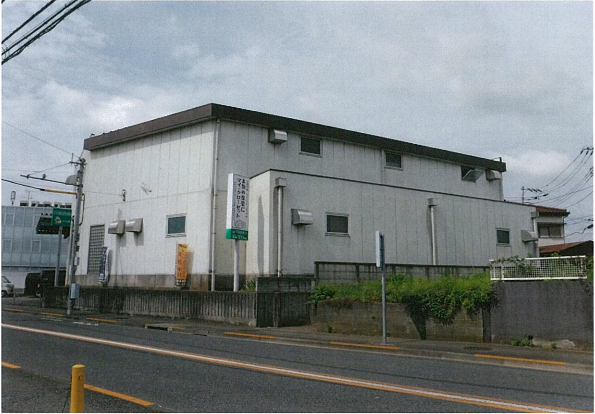
さくら棟 着工前
